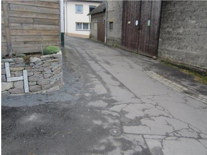
Bild 5: kurze Entwässerungsrinne zum Straßenablauf
