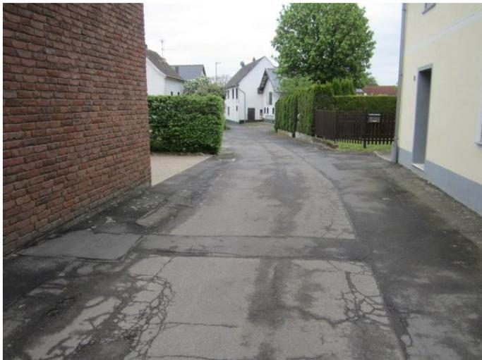
Bild 3: Zustand der Decke
