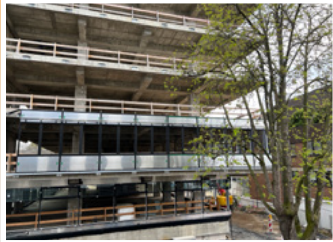
Das Rathaus wird aktuell kernsaniert.
