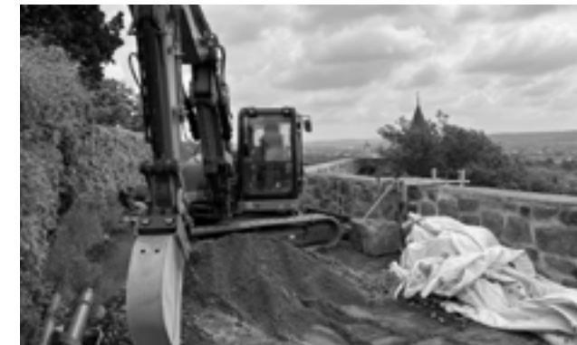
Der Bagger durchpflügt den Johannisgarten.
