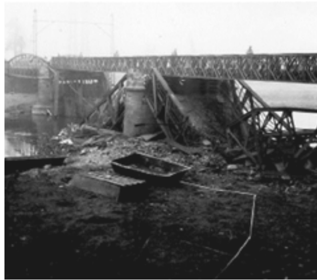
Neuer Aufsatz auf alten Pfeilern an der Mülldorfer Brücke.
