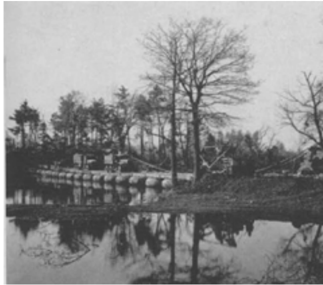
Pontonbrücke über die Agger. Man beachte die Sicherungsmaßnahmen durch Taue auf der Bergseite.
