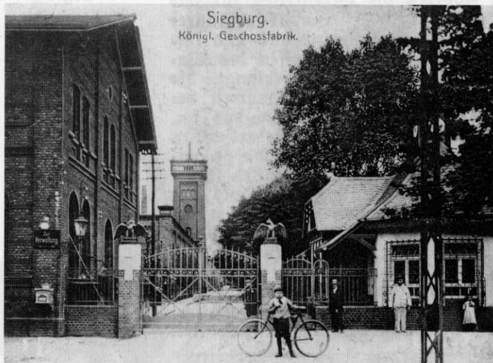
Das Haupttor der Geschoß- fabrik 1909
