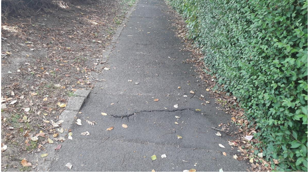
Bild 15: Beispiel Wurzelschaden
