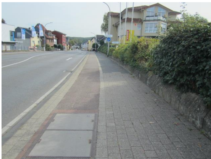
Bild 12: Bereich asphaltierter Radweg
