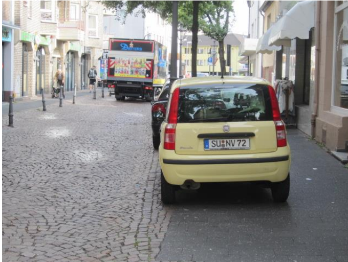
Bild 1 „vorhandenes Straßenprofil in Blickrichtung Osten“
