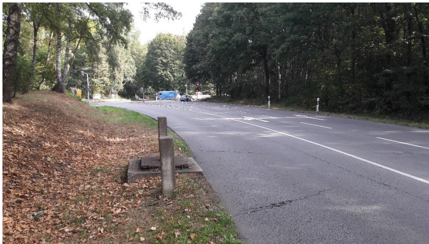
Bild 16: Ausbauzustand Jägerstraße bis B 56
