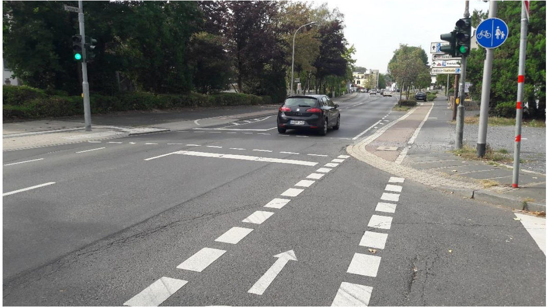
Bild 6: Ausbauabschnitt Tönisbergstraße bis Am Stadion
