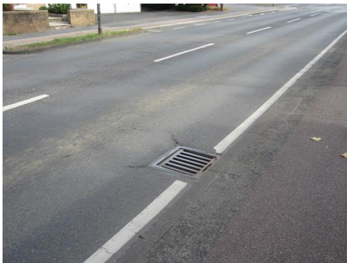
Bild 7: abgesenkter Straßenablauf
