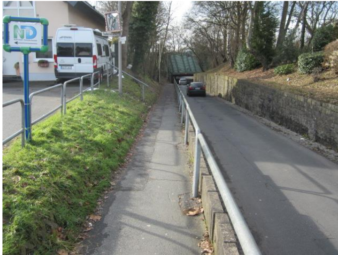
Bild 9: Beginn der Unterführung
