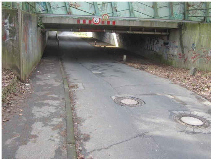
Bild 10: Zustand unter der Autobahn
