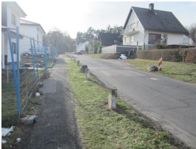
Bild 2 „Gehweganlage von Fahrbahn mit Grünstreifen und Betonpoller getrennt“
