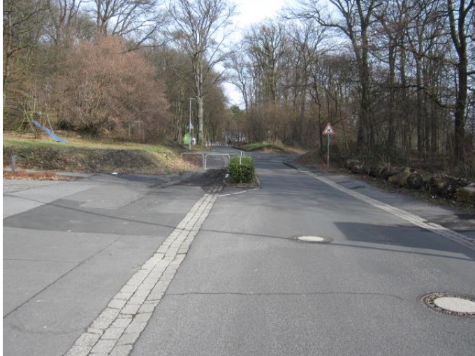
Bild 8: Ausbauzustand im Bereich der Muldenrinnen
