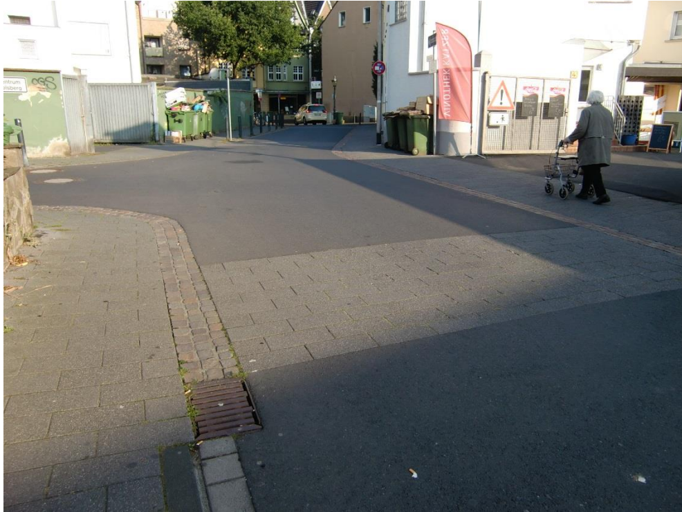
Bild 3: Blick Richtung Holzgasse auf den bereits sanierten Teilabschnitt
