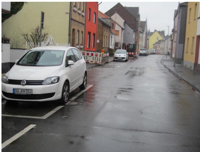
Bild 9: Allgemeinzustand Straße mit markierten Längsparkplätzen
