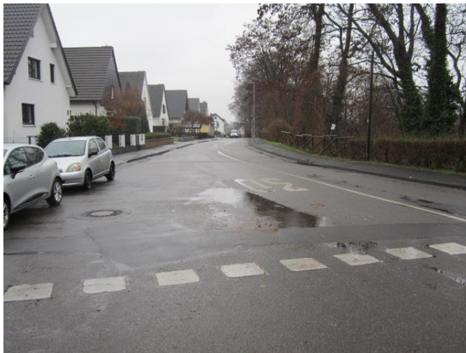
Bild 6: Aufweitung der Fahrbahn vor den Grüner Weg
