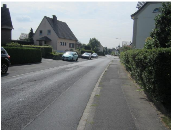
Bild 8: Zustand Gehweg und Fahrbahn
