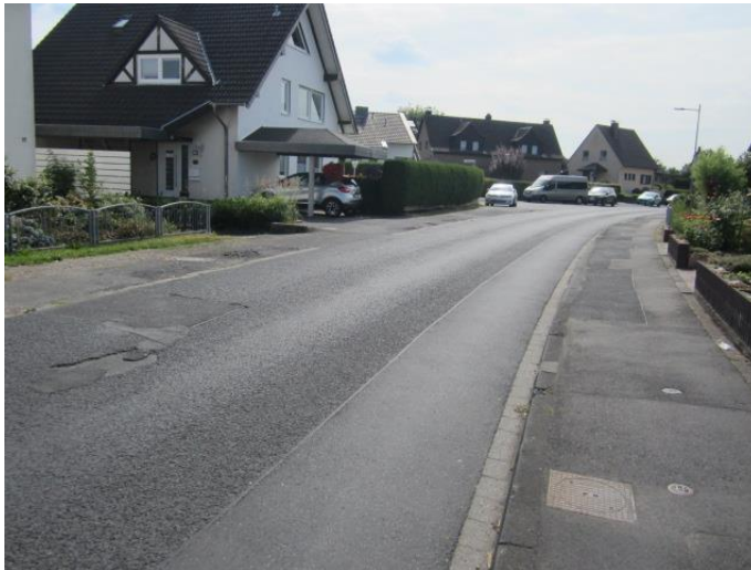
Bild 7: Fahrbahn, Gehweg und Längsaufbruch
