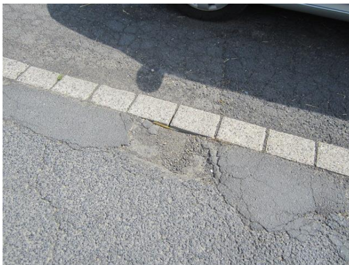
Bild 9: Fahrbahn, Gehweg und Längsaufbruch
