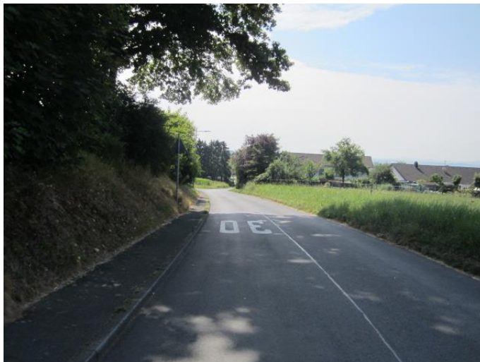
Bild 16: Allgemeinzustand mit östlichem Gehweg
