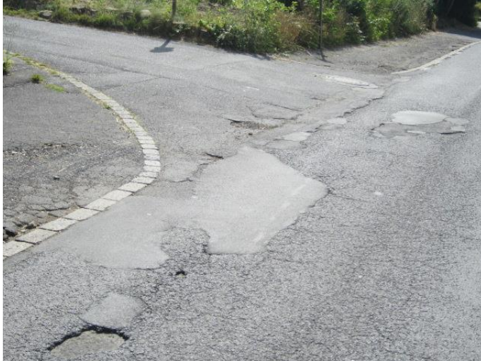
Bild 11: Fahrbahn und Randstreifen Nordseite
