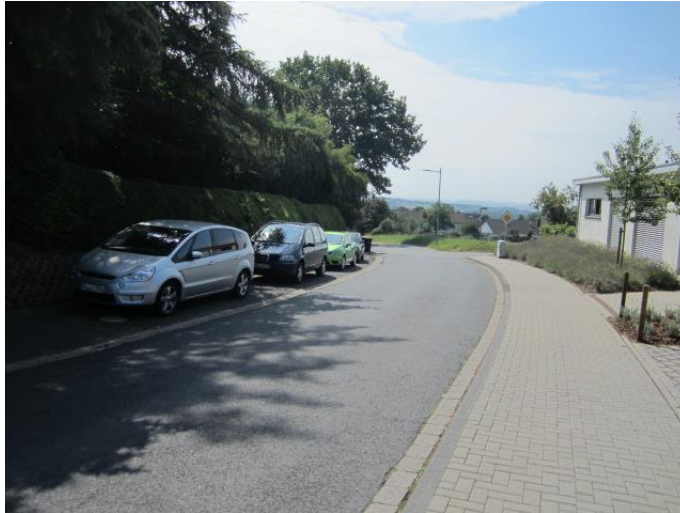
Bild 15: Allgemeinzustand mit Pflasterung des Gehweges vor der Kindertagesstätte
