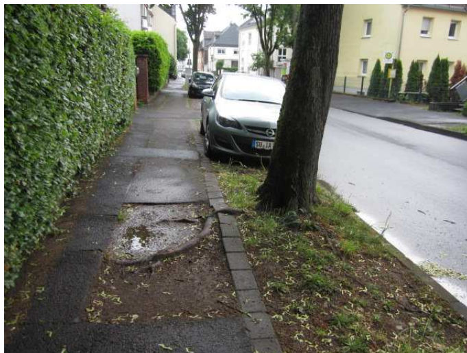
Bild 5: Beispiel für Wurzeln im Gehweg
