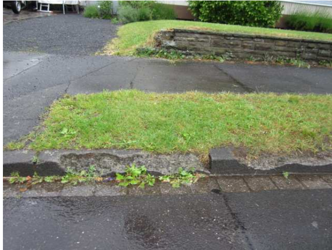
Bild 3: Beispiel schadhafter Borde
