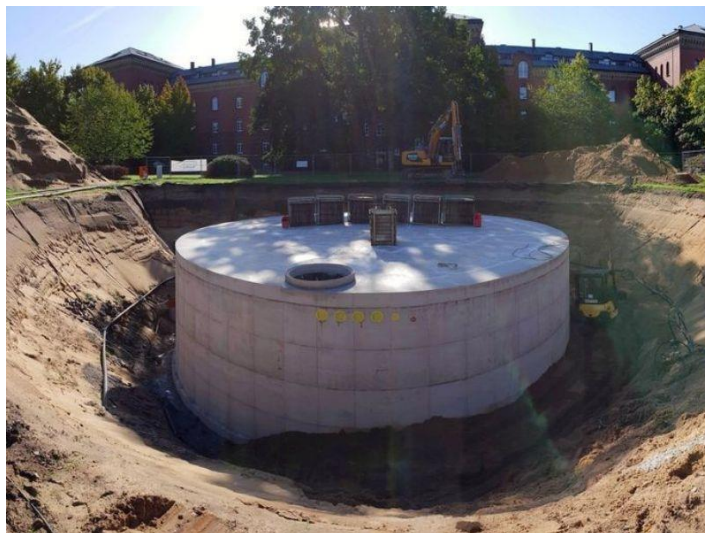
Abbildung 40: Einbau eines Eisspeichers 29
