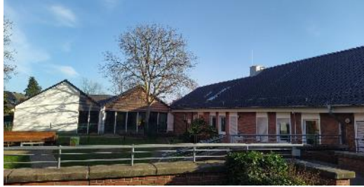
Jugendzentrum Deichhaus und KiTa Deichhaus-Küken, Frankfurter Straße (1)
