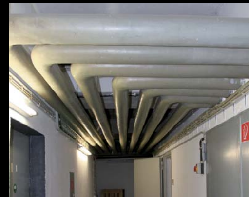
Belastete Rohrleitungsdämmstoffe
