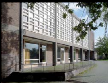
Erweiterung und Sanierung VOF-Verfahren 2010 Fertigstellung I. BA: 2014 Fertigstellung: 2019 Bauwerkskosten: 20,0 Mio. € Auftraggeber: Landeshauptstadt Hannover LP 1-9
