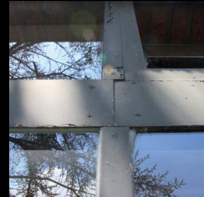
PCB-Belastungen durch Fassadenfarben im EG
