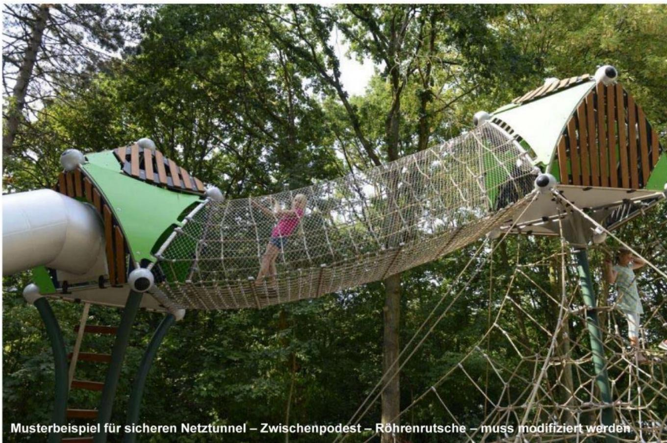
Musterbeispiel für sicheren Netztunnel – Zwischenpodest – Röhrenrutsche – muss modifiziert werden
