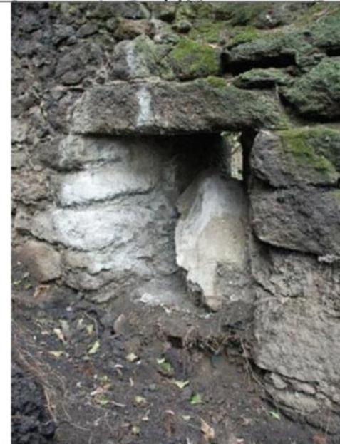
Freigelegte Schießscharte mit ausgebrochener Blockstufe verschlossen
