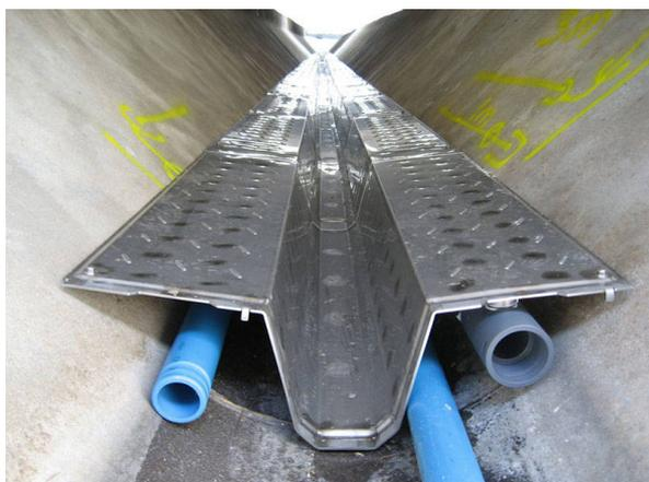
Abb. 84: Wärmetauscher für Abwasserkanäle<sup>47</sup>
