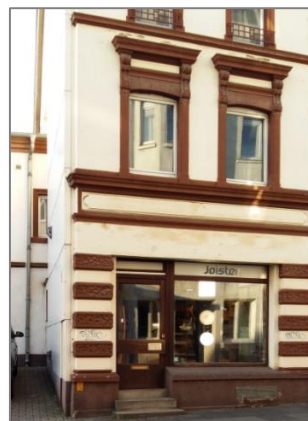
Abb. 3.16: Beispiel für eine erneuerungsbedürftige Fassade
