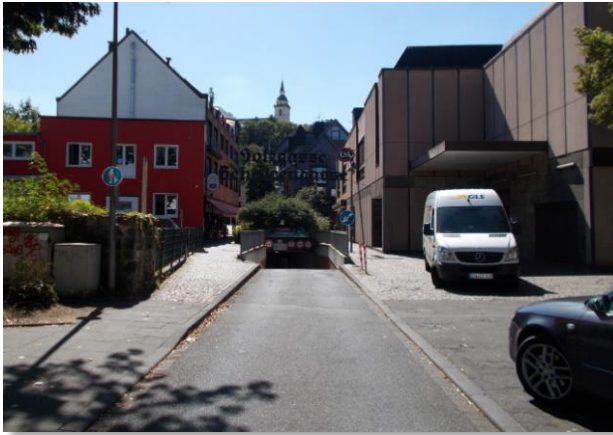
Abb. 3.31: Zufahrt Tiefgarage Holzgasse
