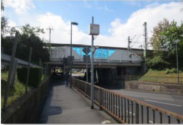
Abb. 3.43: Fußgängerdurchgang Unterführung Mahrstraße
