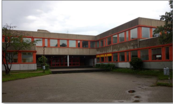
Abb. 3.20: Schulzentrum Neuenhof Komplex Ost
