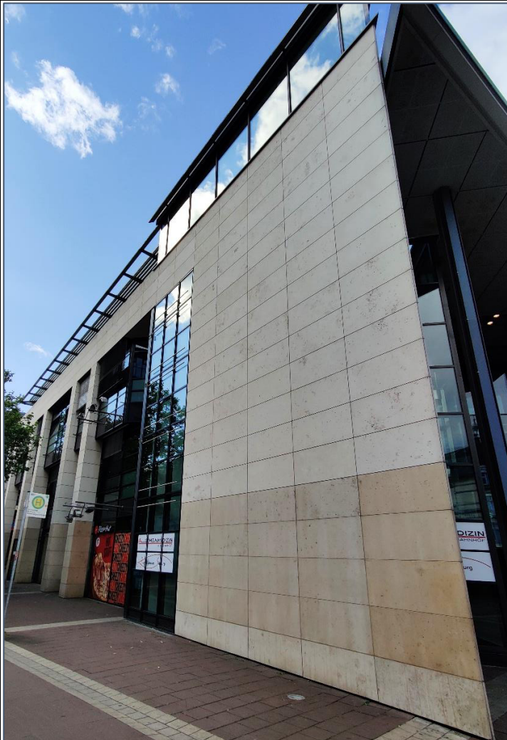
Abbildung 35: Nord-Ost-Fassade des Bahnhofsgebäudes, Potenzialfläche für bodengebundene Fassadenbegrünung
