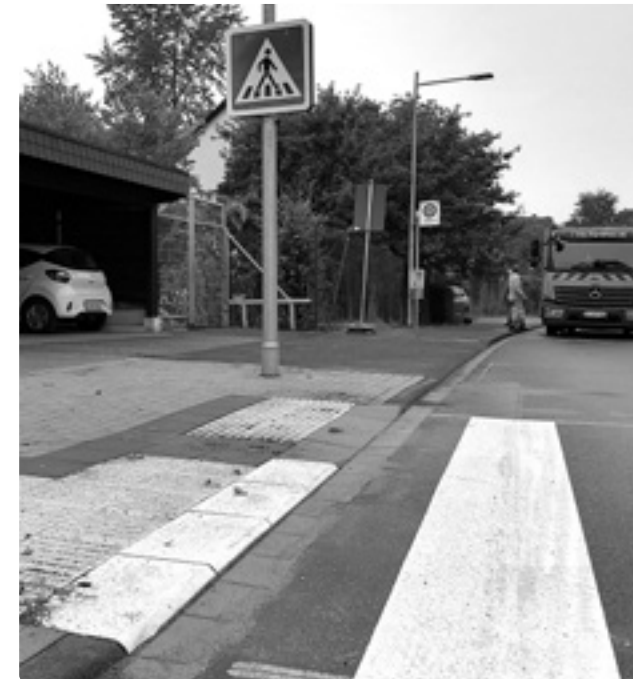
Zebrastreifen mit geteiltem Bordstein: links mit Kante, rechts abgesenkt.
