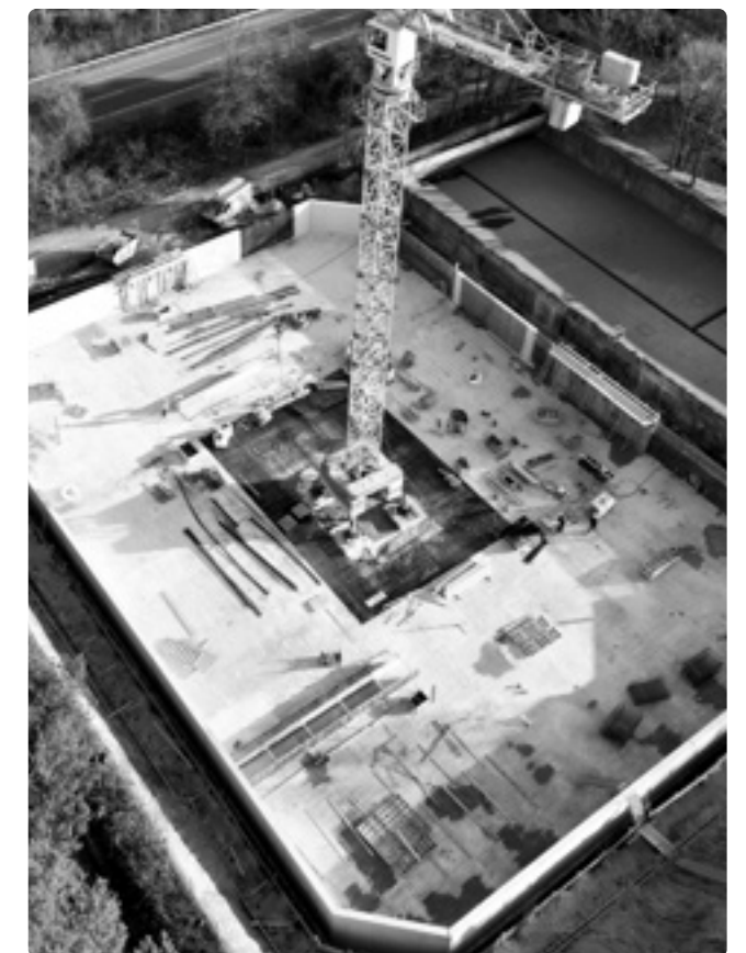
Bau des Rückhaltebeckens auf dem Stallberg.
