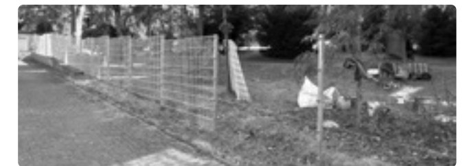
Aufbau der Zaunelemente im August 2025.
