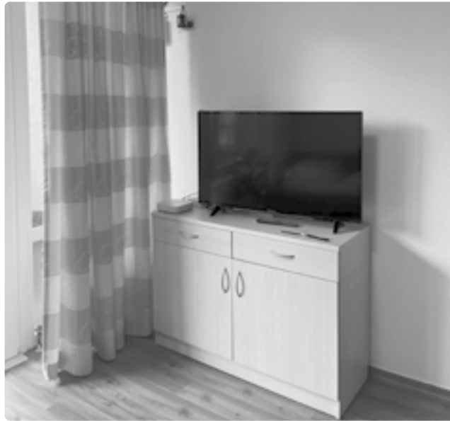
Links oben die optische Klingel. Die weiße Box neben dem TV enthält die Gegensprechanlage, die im Falle eines Sturzes genutzt wird.
