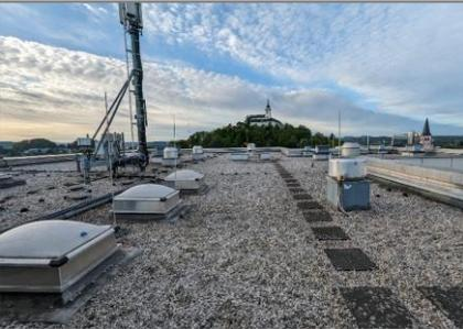
umlaufende Attikausführung mit Zinkblech. Aufbauhöhe ca. 45cm
