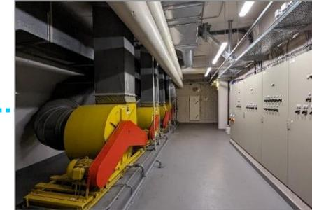
Kältemaschine RWH 1022 KA Emicon, 950 kW Kaltleistung, Baujahr 2000, 2003
