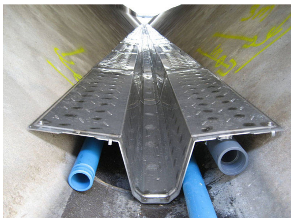
Abb. 84: Wärmetauscher für Abwasserkanäle 47
