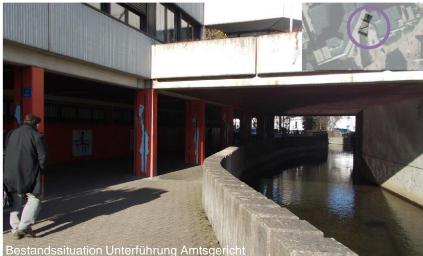
Bestandssituation Unterführung Amtsgericht
