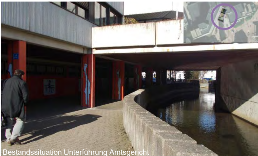
Bestandssituation Unterführung Amtsgericht
