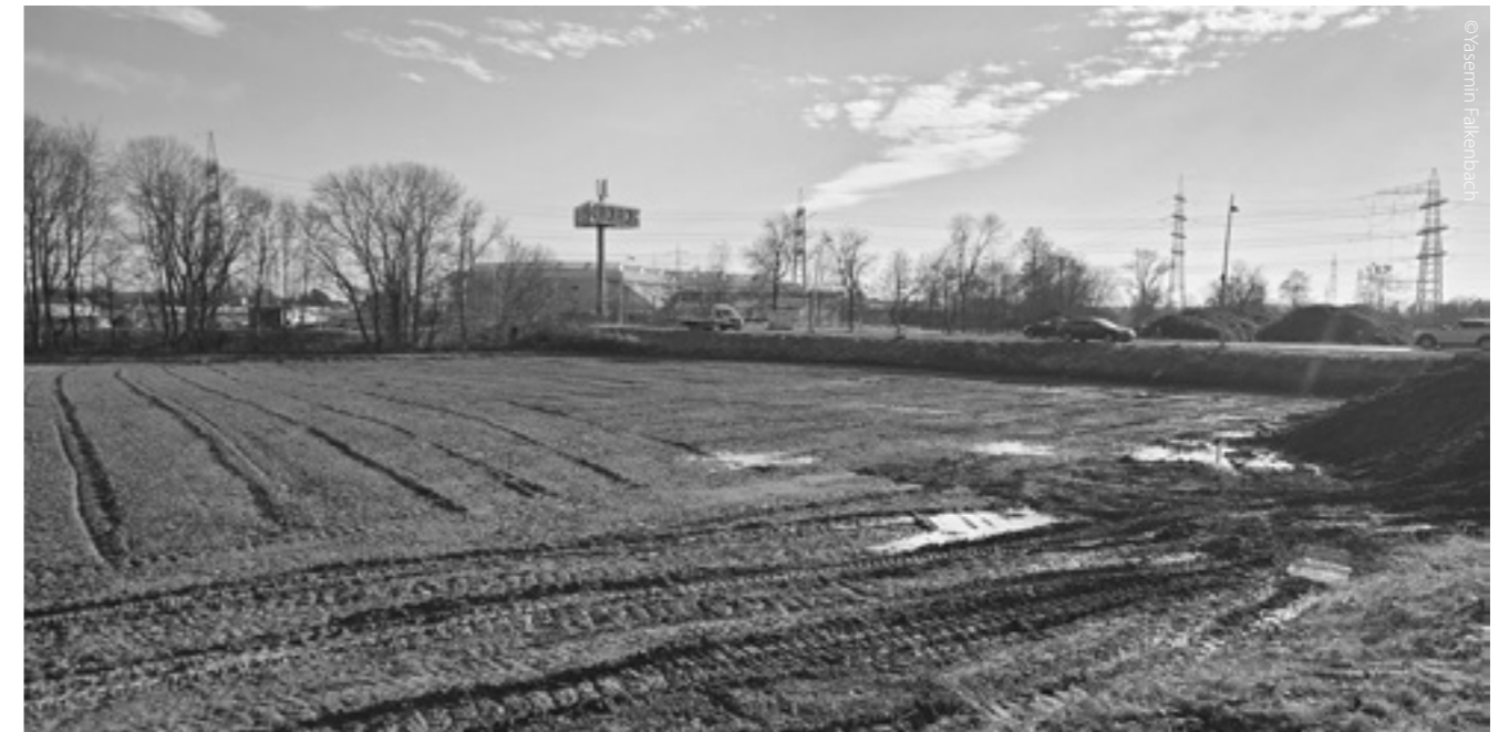
Das Baufeld im Zanger Gewerbegebiet.
