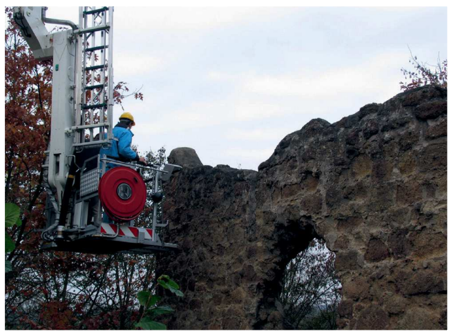
Arbeiten am Denkmal des Uhlrather-Hofs
