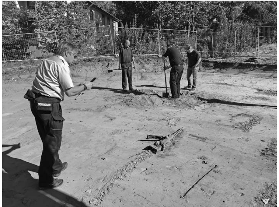
Foto (Van Wingerden): Mitarbeiter des Ordnungsamts und des Amts für Baubetrieb und Immobilienmanagement an der Fundstelle.
