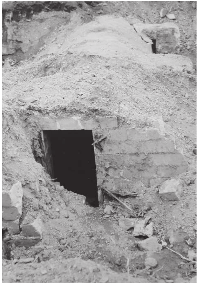
Halb ausgegrabener Luftschutzbunker in der Wilhelm-Ostwald-Straße
