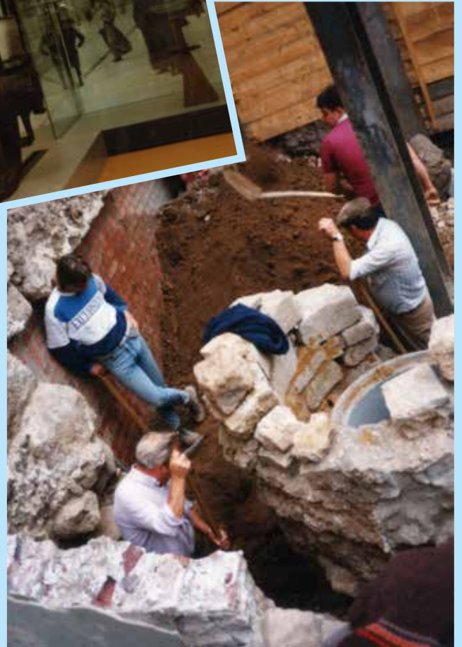
Arbeiten im Keller des neuen Stadtmuseums
