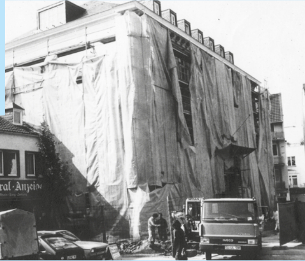
Umbau des Humperdinckhauses am Markt zum neuen Stadtmuseum
