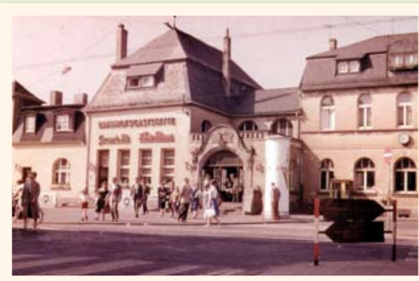
Bahnhof in den 1950er-Jahren: Die Rundbögen-Fenster sind weg, Provisorien herrschen
