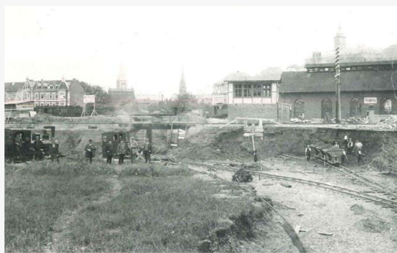
Höherlegung des Bahnhofs 1913. Aus ebenerdigen Bahnübergängen werden an Katharinenstraße/Mahrstraße sowie an der Bonner Straße (Foto) Unterführungen. Der Lokschuppen rechts wird abgerissen.
