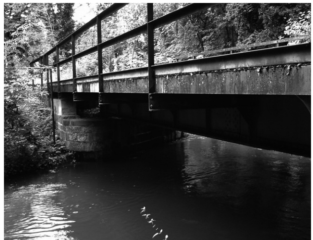
Die Mühlengrabenbrücke von Osten gesehen.
