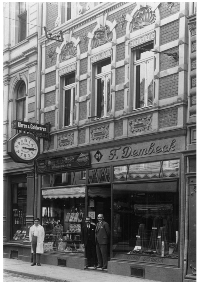
Haus Kaiserstraße 26 in den 30er Jahren
