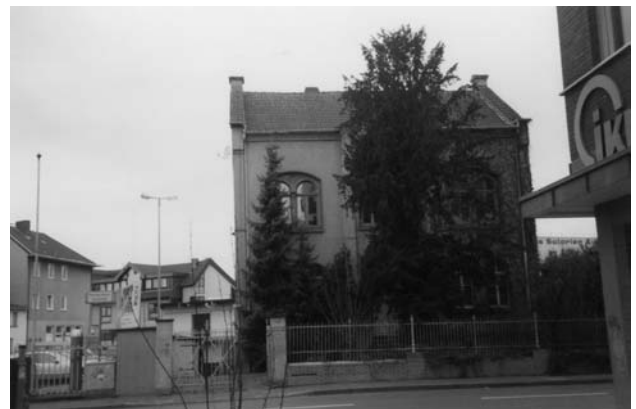
Gelände Wilhelmstraße (ehemalige Henrichgelände) Abbruch am 20.05.2006 (Foto vom 18.01.2005)
