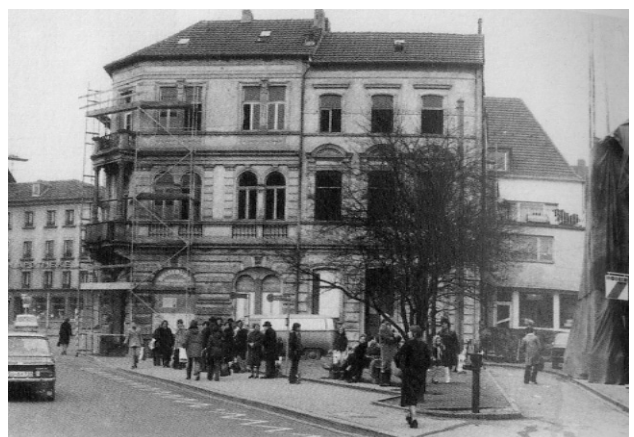
Der Hühnermarkt während des Abrisses der Altbebauung, 1973
