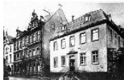
Pastorat mit Außentreppe
