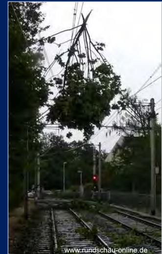
25.07.2013: Sturmschäden nach Unwetterereignis
