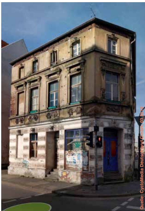
Abb. 2.1.2: Wohnhaus Wilhelmstraße 75 – Gefährdung durch Leerstand/Zustand, Quelle: Cyclomedia Streetsmart 3.2019
