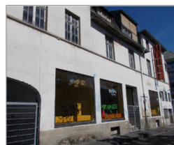
Abb. 3.15: Modernisierungsbedarf und Leerstand im Rathausumfeld
