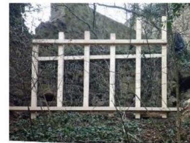
Temporäre Holzabfangung, Zustand 2012
