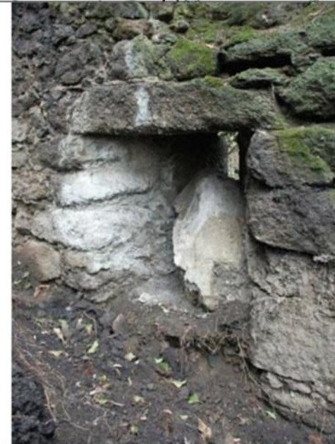
Freigelegte Schießscharte mit ausgebrochener Blockstufe verschlossen
