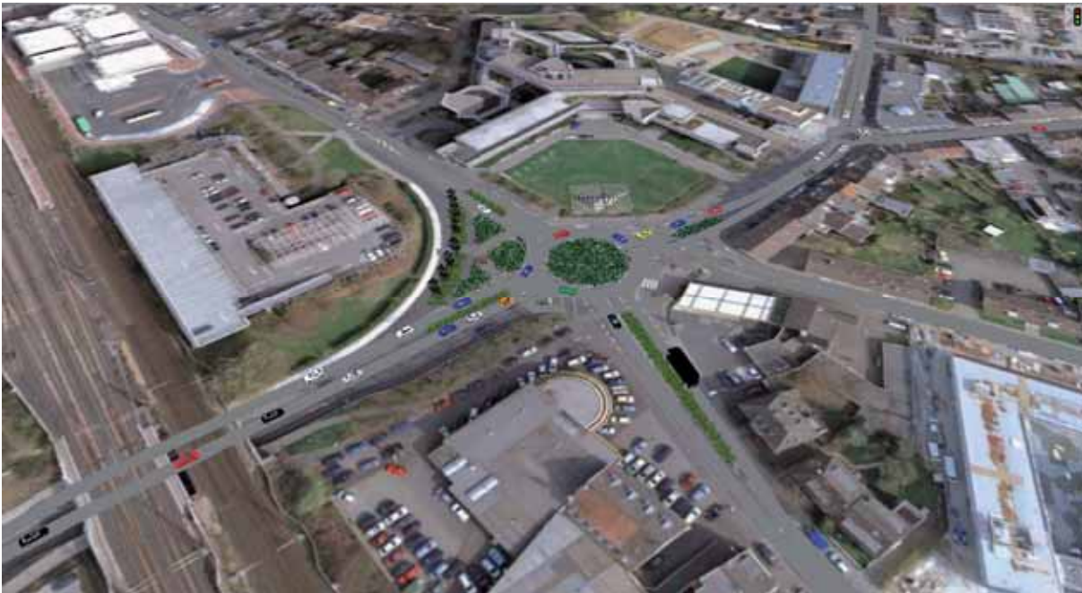
Bild 11.5-6: Ausschnitt aus der Simulation für den Knoten Bonner Straße / Wilhelmstraße / Kaiser-Wilhelm-Platz / Frankfurter Straße für den Nachmittagsbereich, Kreisverkehr
