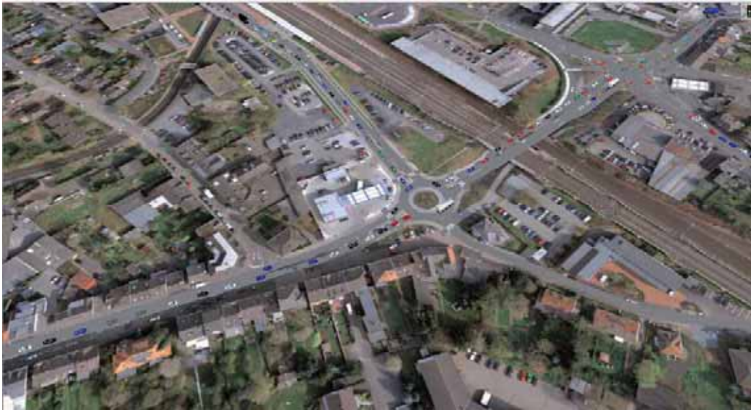
Bild 11.5-2: Ausschnitt aus der Simulation am Knotenpunkt Bonner Straße / Konrad-Adenauer-Allee für den Nachmittagszeitbereich, derzeitige bauliche Situation
