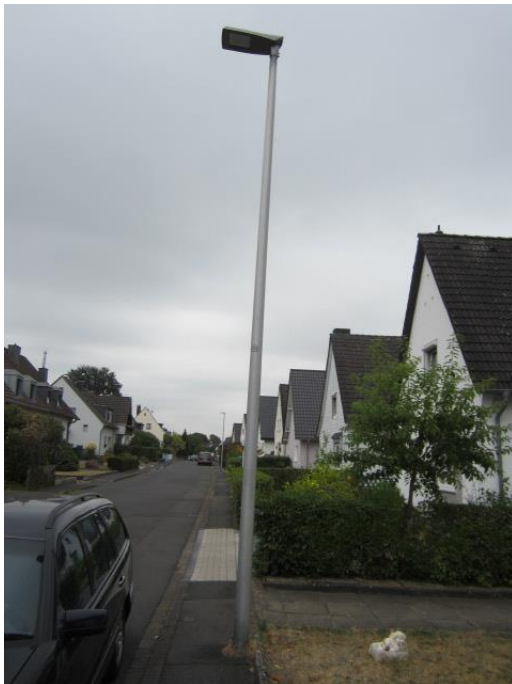
Bild 2 „Straßenbeleuchtung mit kurzem gepflasterten Gehwegbereich“
