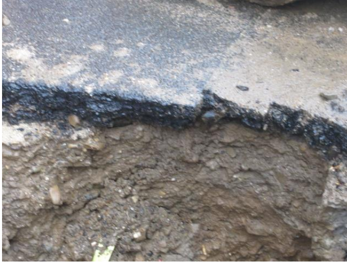
Bild 10: offene Baugrube Gehweg mit wenigen Zentimetern Asphaltdecke
