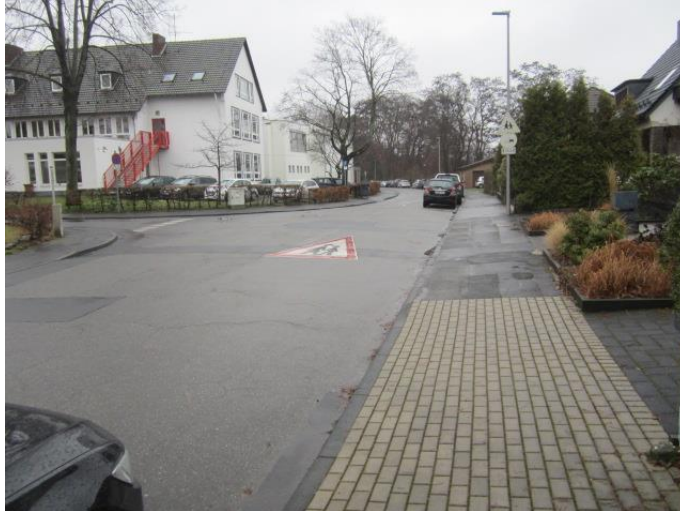
Bild 1: vorh. Straßenlaterne als Beispiel (dieser Lampentyp steht im gesamten Untersuchungsabschnitt)
