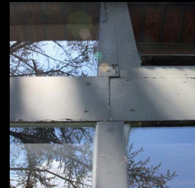
PCB-Belastungen durch Fassadenfarben im EG
