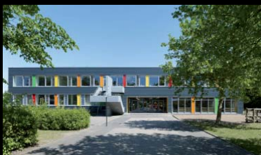
Paul-Gerhardt-Schule in Lübeck Fassadensanierung VOF- Verfahren 2007 Fertigstellung: 2008 Bauwerkskosten: 2,2 Mio. € Auftraggeber: Stadt Lübeck LP 1-9
