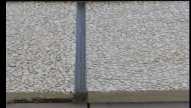
PCB-haltige Fugenmaterialien
