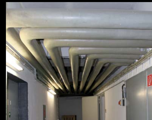
Belastete Rohrleitungs-dämmstoffe
