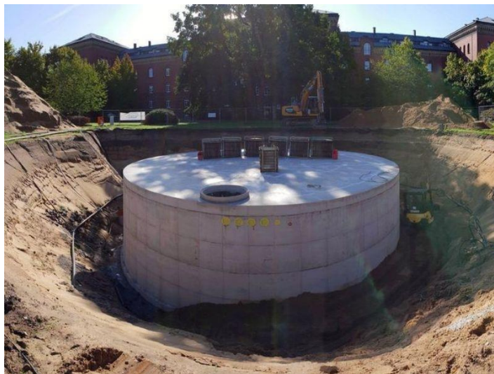
Abbildung 40: Einbau eines Eisspeichers 29
